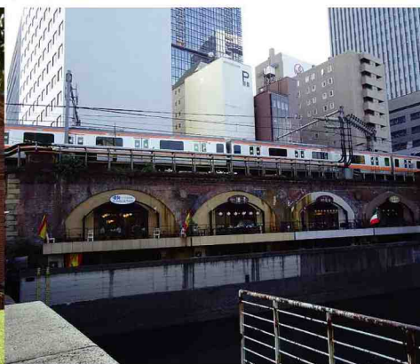
紅梅河岸高架橋
