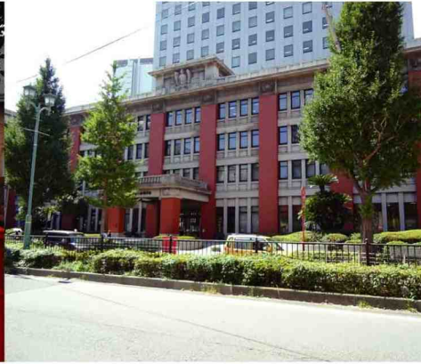
横浜第二合同庁舎(旧横浜生糸検査所)
