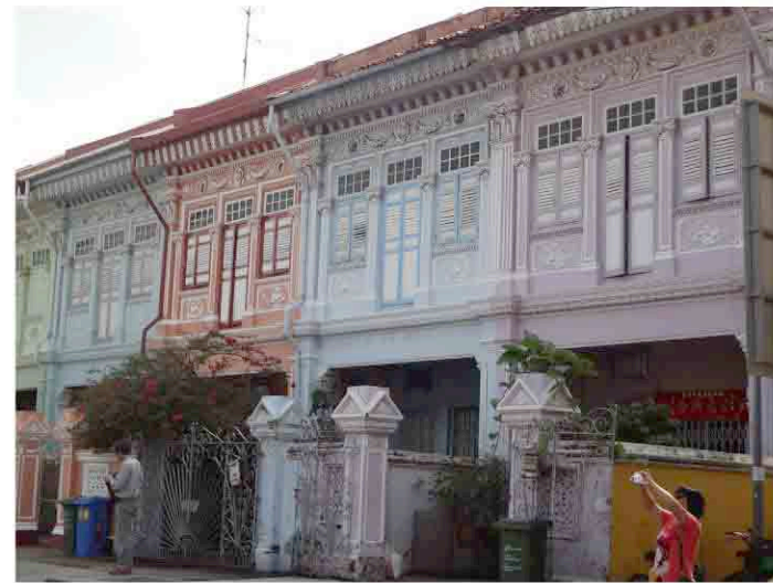
カトン地区の建物
